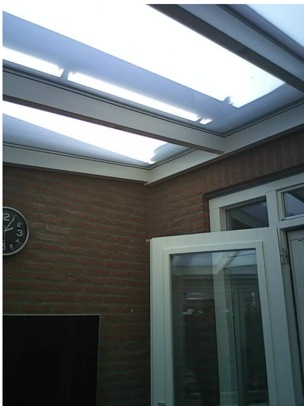
Aansluiting serre tegen oorspronkelijke achtergevel (zie opmerking 3 bij 'geconstateerde naden en kieren' in lekcheck verslag)
