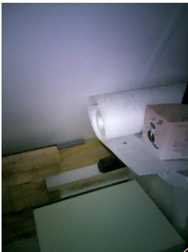
Aansluiting dakelementen op houten muurplaat (zie opmerking 5 bij 'geconstateerde naden en kieren' in lekcheck verslag)
