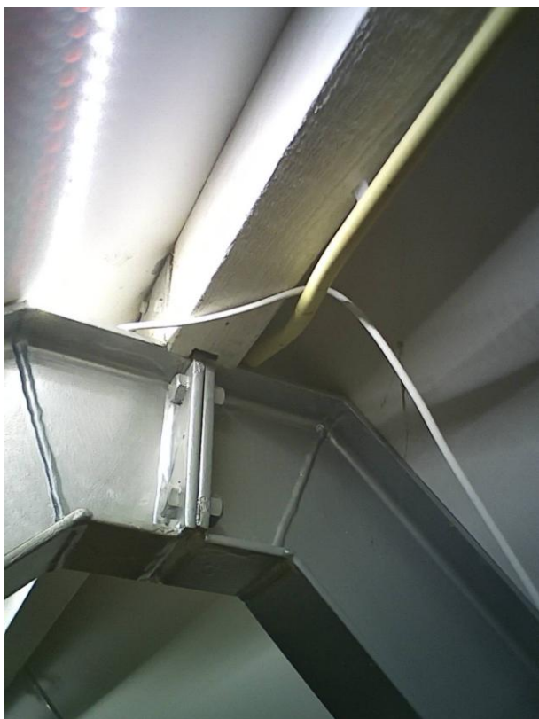
Aansluiting dakelementen onderling (boven nokbalk op zolder) (zie opmerking 9 bij 'geconstateerde naden en kieren' in lekcheck verslag)
