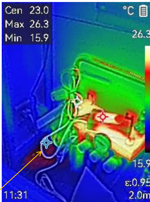
Verdeler vloerverwarming in bijkeuken (zie opmerking 5 bij 'geconstateerde naden en kieren' in lekcheck verslag)
