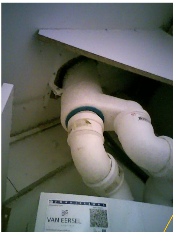
Dakdoorvoer cv-ketel op zolder (zie opmerking 8 bij 'geconstateerde naden en kieren' in lekcheck verslag)
