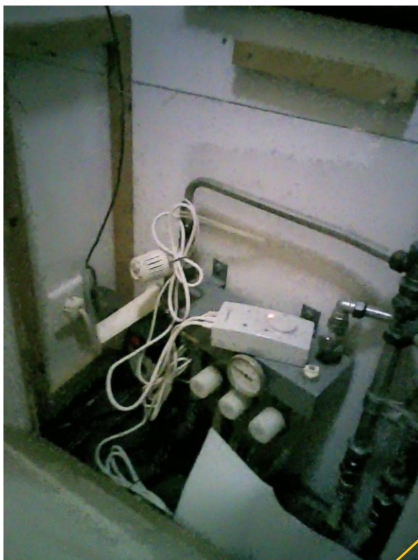
Verdeler vloerverwarming in bijkeuken (zie opmerking 5 bij 'geconstateerde naden en kieren' in lekcheck verslag)
